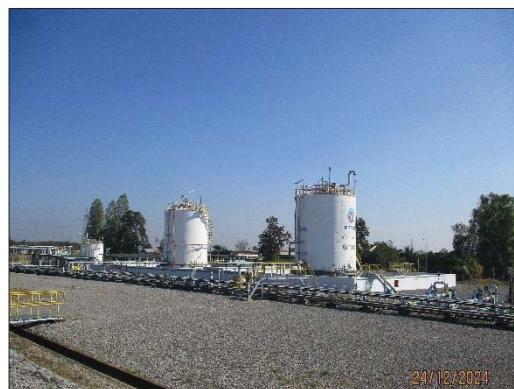
ภาพถ่ายที่ 2.2-7 คั่นคอนกรีตล้อมรอบถังคอนเดนเสท
