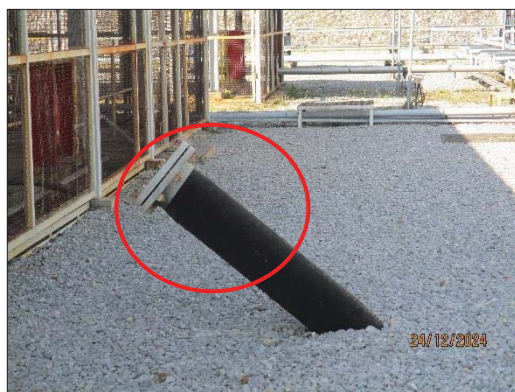
ภาพถ่ายที่ 2.2-14 ฝาท่อ หรือ ที่อุดปิดปลายท่อซึ่งไม่ต่อกับอุปกรณ์อื่น
