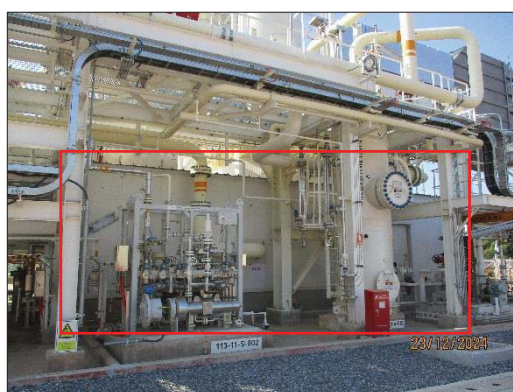
ภาพถ่ายที่ 2.2-18 อุปกรณ์ลดระดับเสียงเป็นพิเศษ (Extra Acoustic Enclosure)
