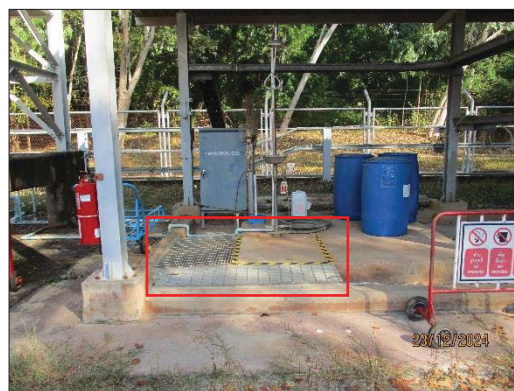
ภาพถ่ายที่ 2.2-8 บ่อรับน้ำปนเปื้อนบริเวณพื้นที่จัดเก็บสารเคมี
