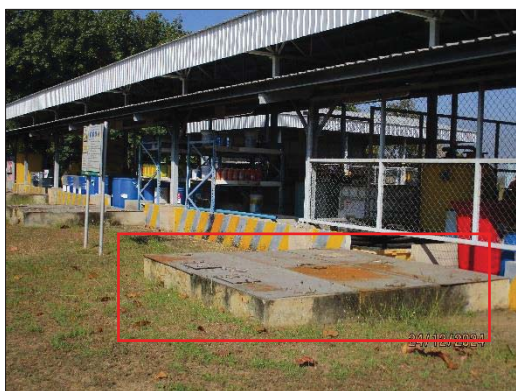
ภาพถ่ายที่ 2.2-8 บ่อรับน้ำปนเปื้อนบริเวณพื้นที่จัดเก็บสารเคมี
