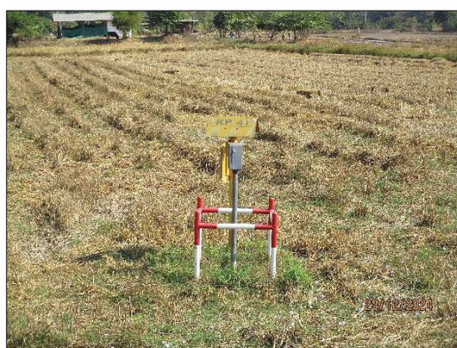
ภาพถ่ายที่ 2.2-28 จุดตรวจสอบการผูกเรือนของผิวท่อ (Cathodic Protection Test Point)
