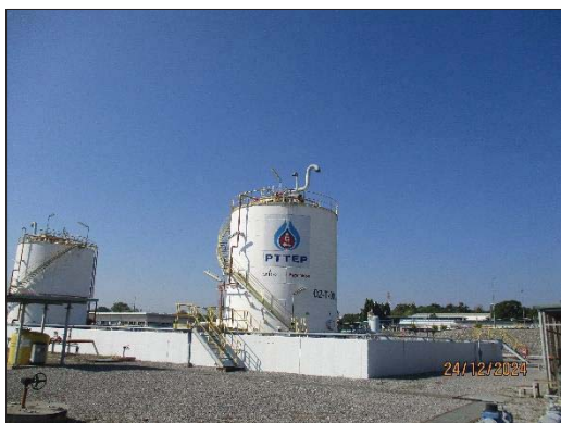
ภาพถ่ายที่ 2.2-7 คั่นคอนกรีตล้อมรอบถังคอนเดนเสท
